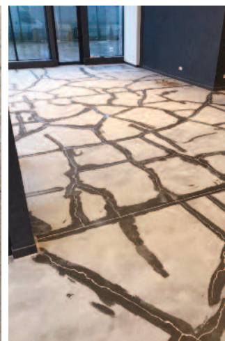
Reparații cu mortar epoxidic a fisurilor
