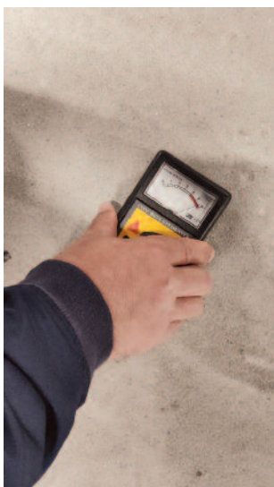
Verificarea umidității cu metoda Tramex
